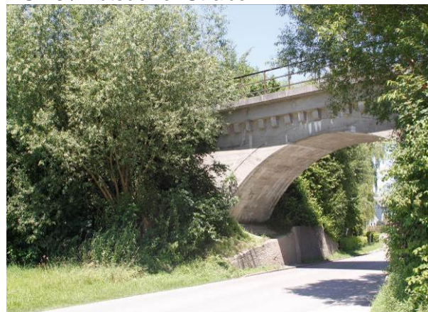
Foto 16: Bahndammunterführung Kreisstraße BGL 3 / Abtsdorfer Straße
