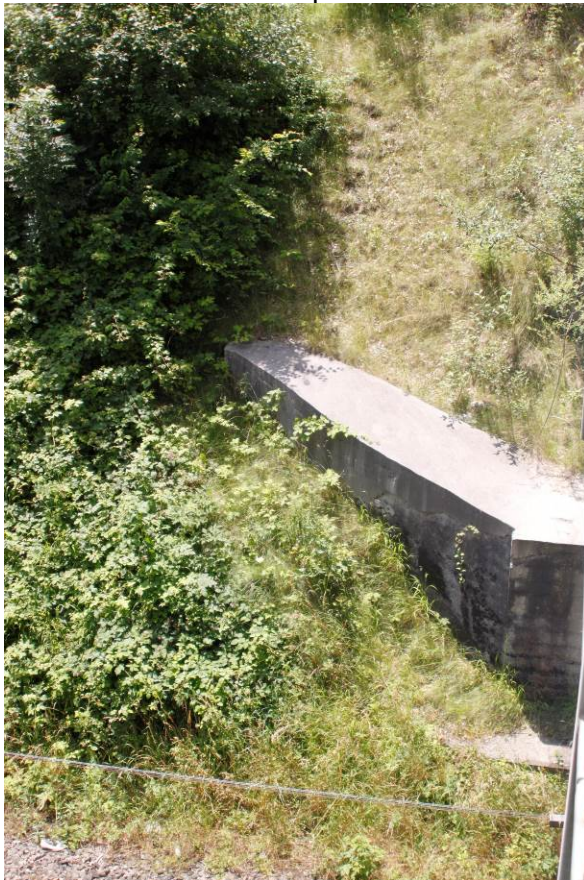
Foto 3: Böschungen an der Brücke über die Bahnlinie nördlich Hauspoint
